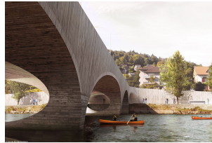
Aarebrücke, Uferweg, Sicht Richtung Norden
