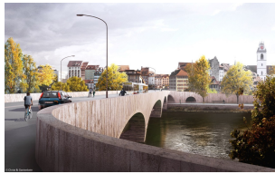
Neue Aarebrücke, Blick auf Aarau
