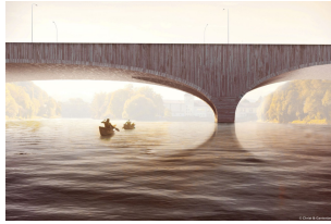
Aarebrücke, Richtung Westen, im Hintergrund das Wasserkraftwerk
